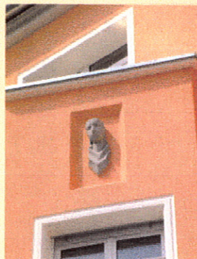
9 Nach der Sanierung wirken die in die Fassade eingestreuten figürlichen Darstellungen wie eingerahmt.
