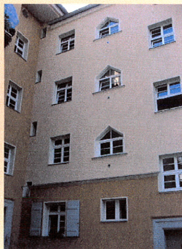
4 Nachher: Die Loggien wurden im Zuge der Sanierung geschlossen. So wurde mehr Wohnraum gewonnen.
