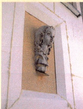
8 Die Gestaltungselemente wurden sorgfältig gereinigt. Darum herum wurde das WDVS ausgespart.
