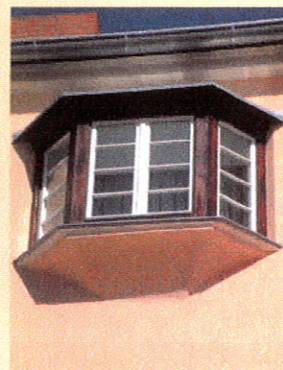
11 Die Vielzahl der Erkerformen bestimmt das Erscheinungsbild der Wohnsiedlung und erfordert Detailarbeit.
