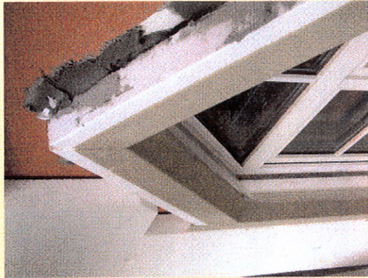
5 + 6 Alle Nachbildungen von Gestaltungselementen, wie hier eine Fensterleibung, sind Sonderanfertigungen. Mitunter musste das Planungsteam zuvor die optimale Passform ausprobieren.
