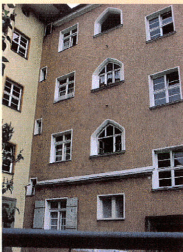
3 Voher: Die teilweise noch offenen Mini-Loggien waren wärmedämmtechnisch nicht beherrschbar und kaum nutzbar.
