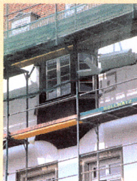
10 Für die Erker wurden die Dämmplatten maßgenau zugeschnitten und genau eingefügt.
