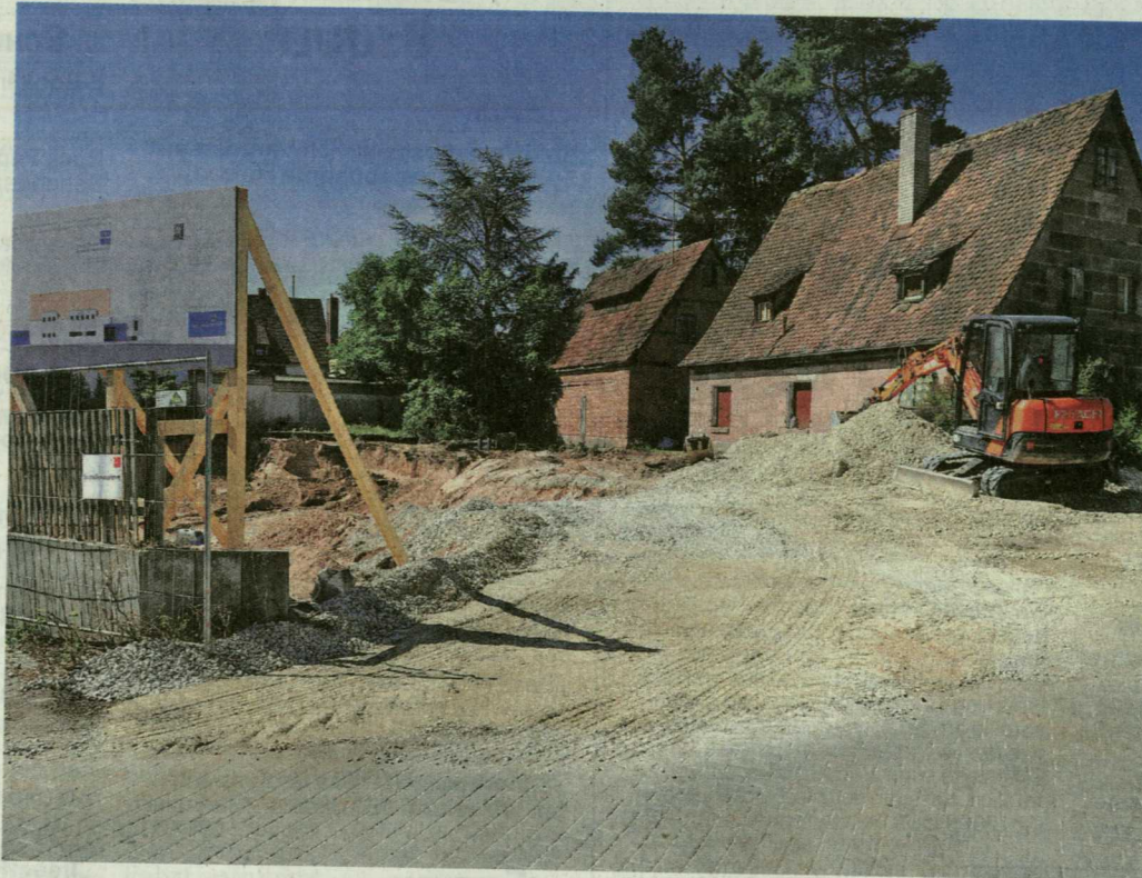
Noch klappt im Schwaiger Ortszentrum eine Baugrube. Hier entsteht die neue Diakoniestation – die Planungen dafür laufen bereits seit sechs Jahren. Foto: Brinek
