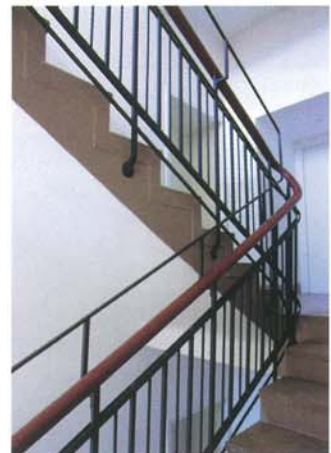
Die bauzeitlichen Treppengeländer wurden kaum wahrnehmbar an heutige Höhenvorgaben angepasst
