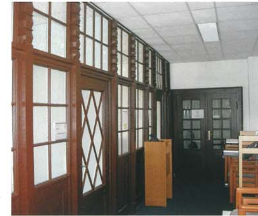
Kontorflur im Vorzustand
