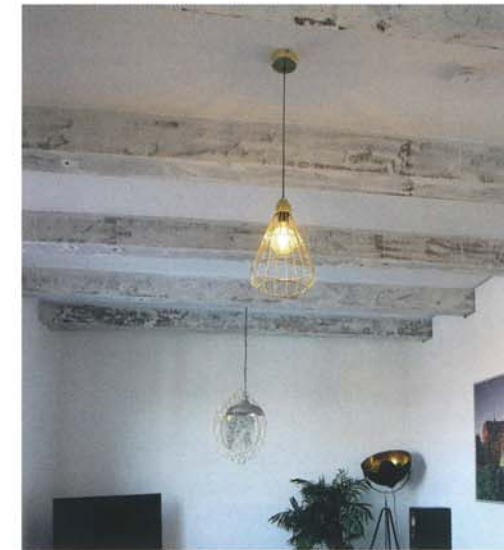
Die originale Betondecke wurde in einigen Wohnungen bewusst in Szene gesetzt
