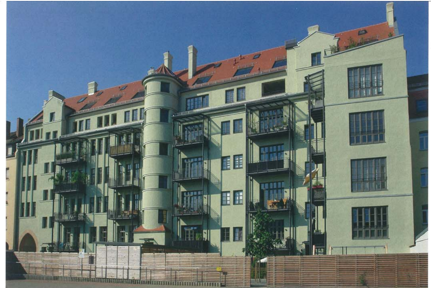
An der östlichen Fassade zum Hof hin wurde ein Treppenturm entfernt und Balkone angefügt
